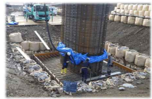
橋梁の耐震補強工事
